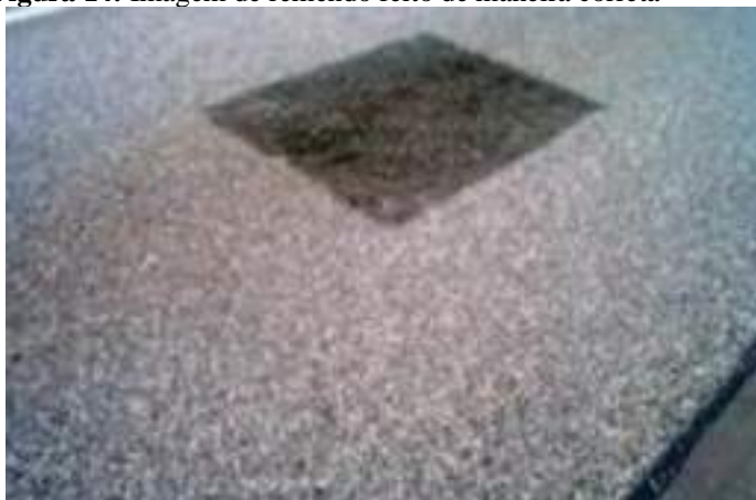
Figura 14: Imagem de remendo feito de maneira correta
