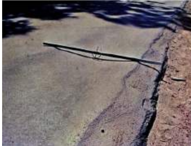
Figura 4: Afundamento
