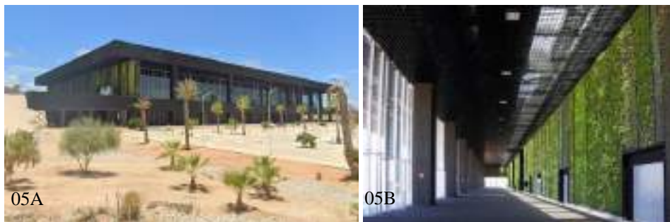
Figura 05A e 05B: Fachada verde.
