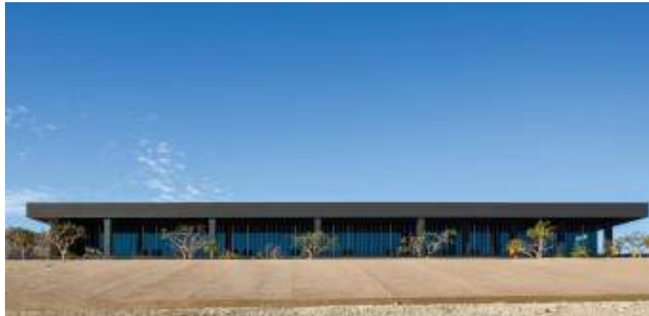
Figura 04: Fachada, Centro Internacional de Convenções Los Cabos
