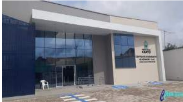
Figura 16: Fachada: Centro de atendimento ao cidadão
