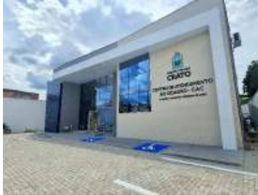
Figura 14: Vista exterior: Centro de atendimento ao cidadão
