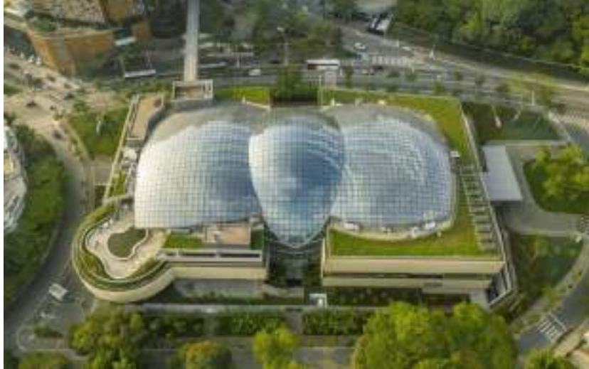
Figura 10: Vista aérea da cobertura do edifício.
