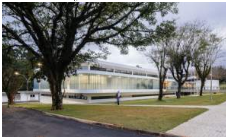
Figura 25: Fachada do edifício.
