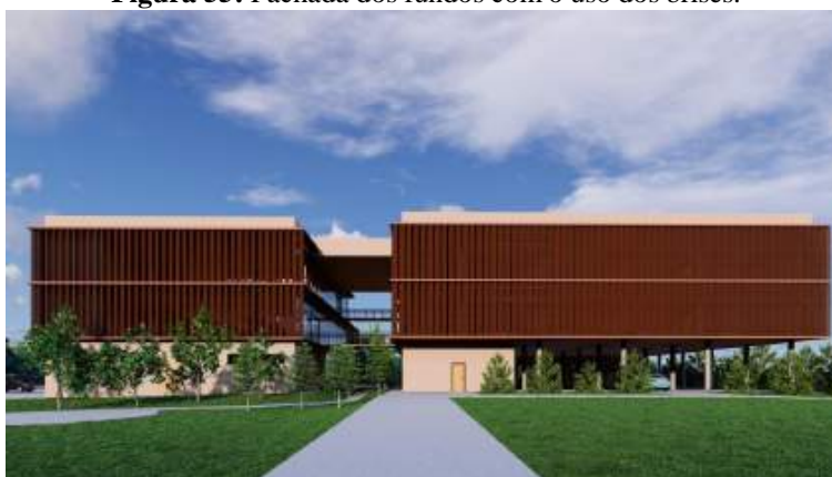
Figura 55: Fachada dos fundos com o uso dos brises.
