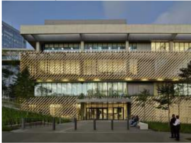
Figura 14: Uso de brises na fachada.
