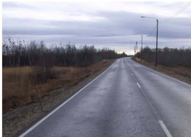
Figura 10 - Afundamento de trilho de roda
