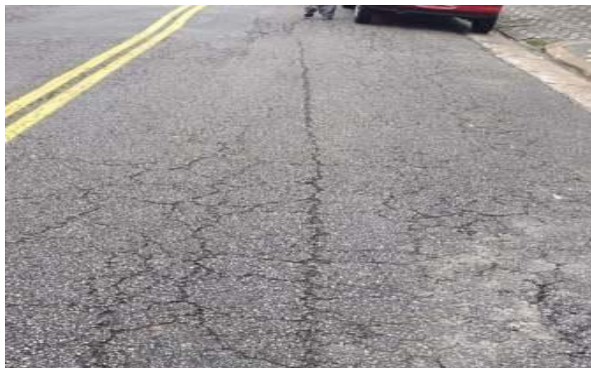
Figura 2 - Trincas longitudinal
