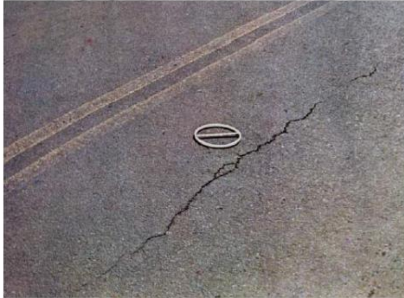
Figura 3 - Trincas longitudinal
