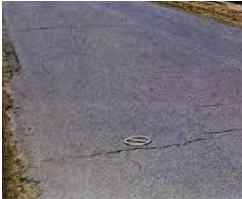
Figura 1- Trinca transversal
