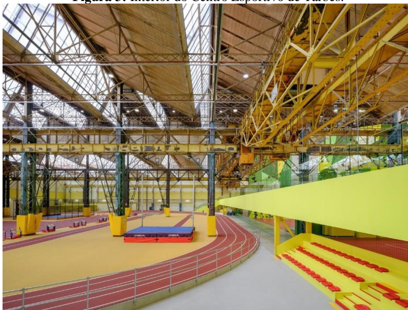
Figura 3: Interior do Centro Esportivo de Tarbes.
