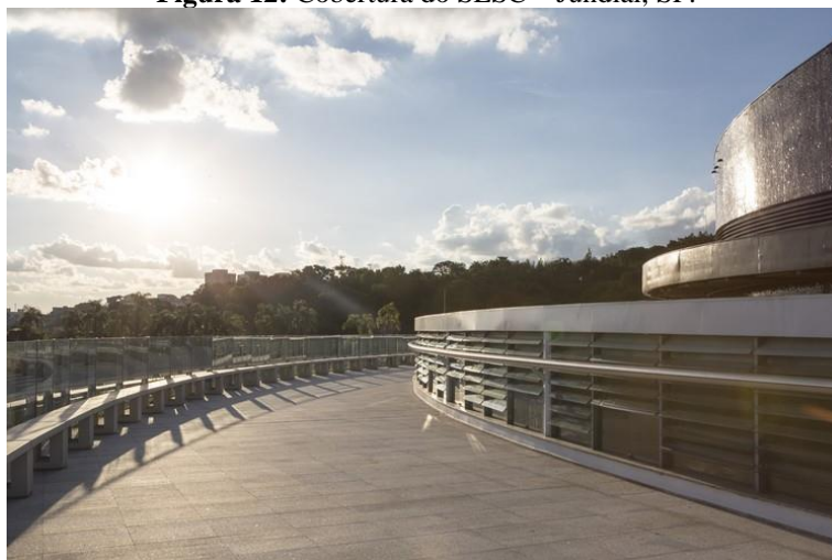
Figura 12: Cobertura do SESC – Jundiaí, SP.
