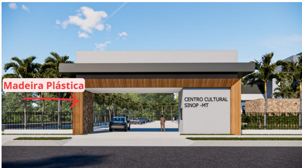
Figura 37: Detalhes guarita com madeira plástica.
