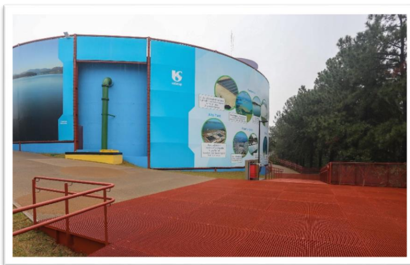
Figura 15 - Reservatório com painel lúdico com informações do ciclo da água
