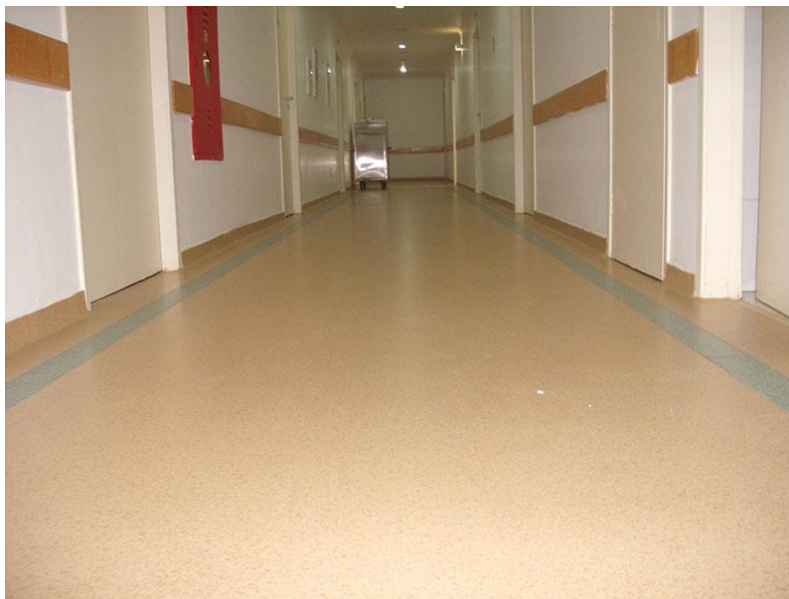
Figura 70: Piso vinílico em manta.
