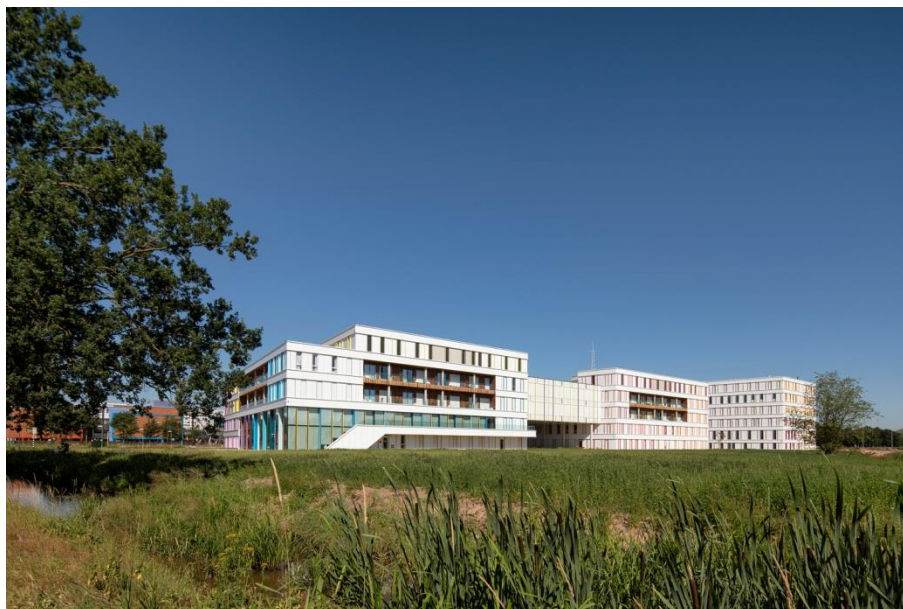
Figura 05: Centro de Oncologia Princess Máxima.
