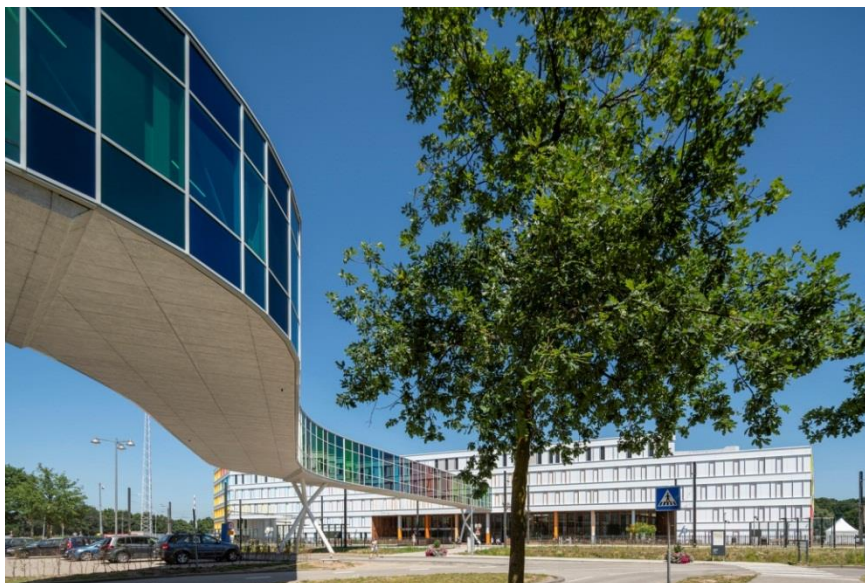
Figura 12: Ponte do Centro de Oncologia Princess Máxima.
