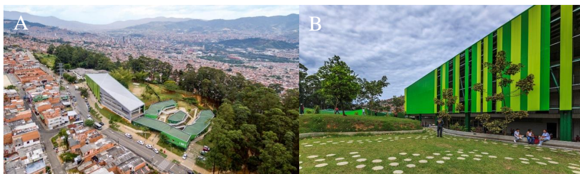
Figura 7: Centro Educativo Montecarlo Guillermo Gaviria Correa (a) Entorno e (b) Fachada.
