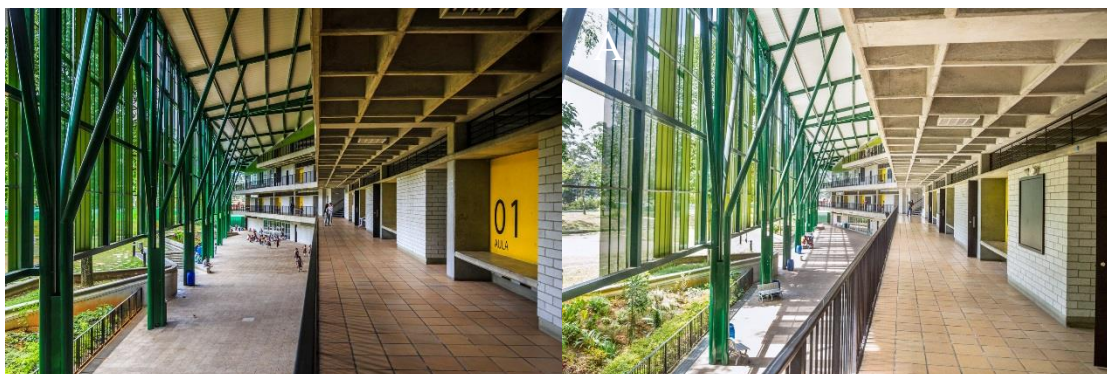
Figura 12: Centro Educativo Montecarlo Guillermo Gaviria Correa (a) detalhe colunas metálicas I (b) detalhe colunas metálicas II
