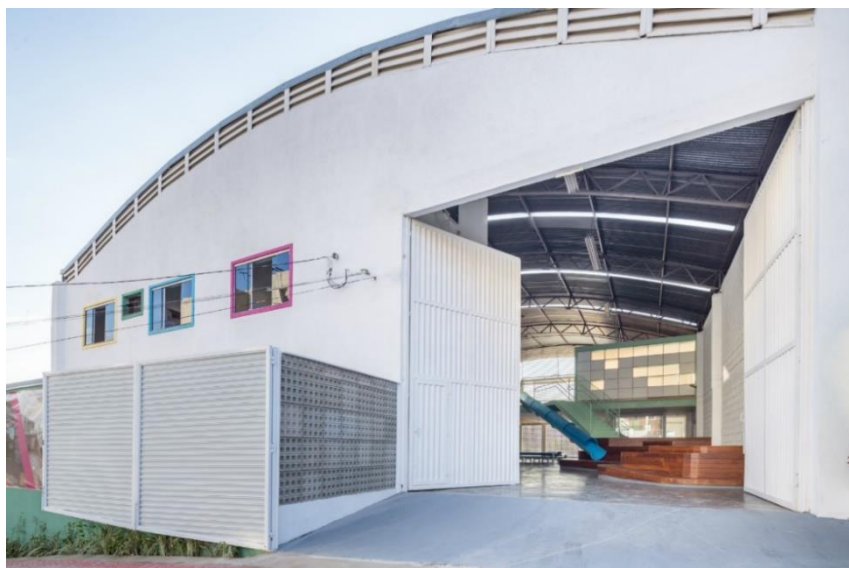
Figura 2: Escola Casa Fundamental entrada principal
