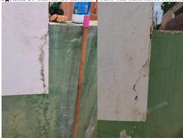
Fotografia 5: trincas no mesmo ponto em diferentes residências
