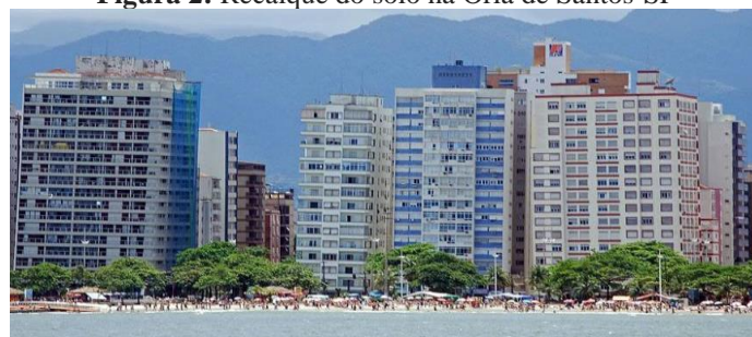
Figura 2: Recalque do solo na Orla de Santos-SP
